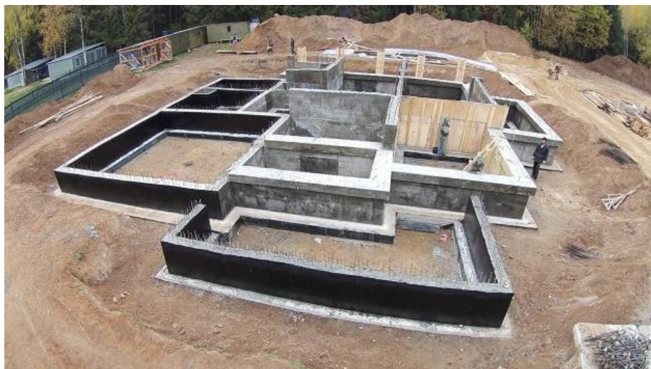
Рисунок 20 – Ленточный монолитный фундамент [22]
