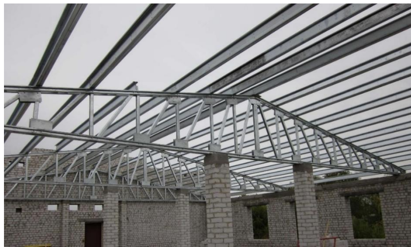
Рисунок 23 – Опираение металлических ферм на несущие стены [25]
